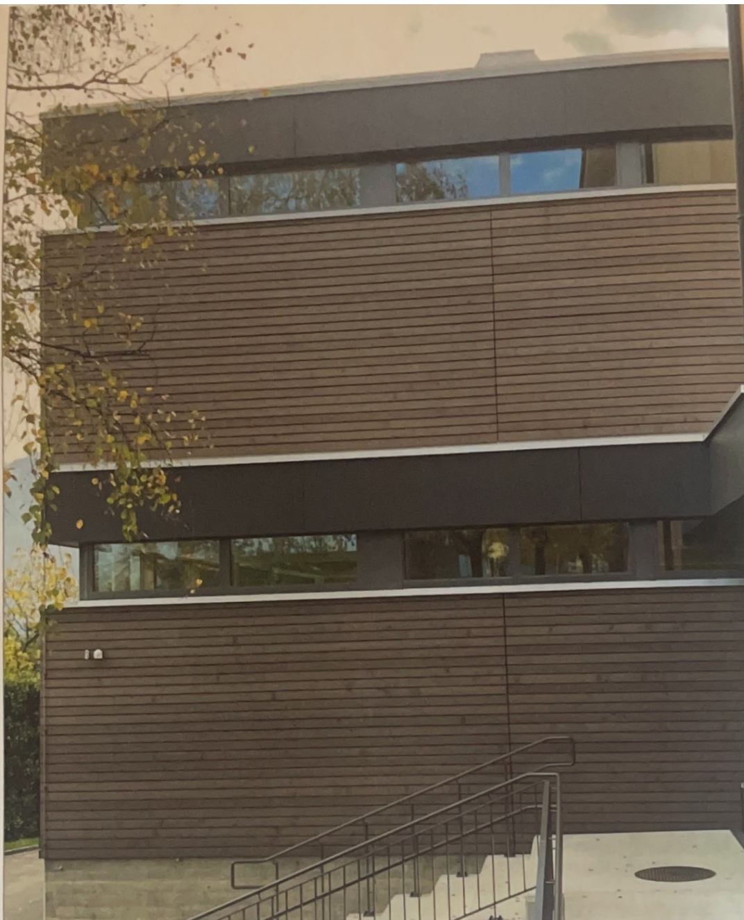
L'esterno della scuola dell'infanzia Collina d'oro: un esempio di prefabbricato in legno e vetro, certificato Minergie A (DL Studio mn Sagl)
