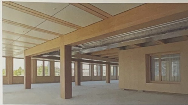
Impiego del faggio stratificato nel multipiano. Suurstoffi Risch Rotkreuz - 10 piani, 2018.
